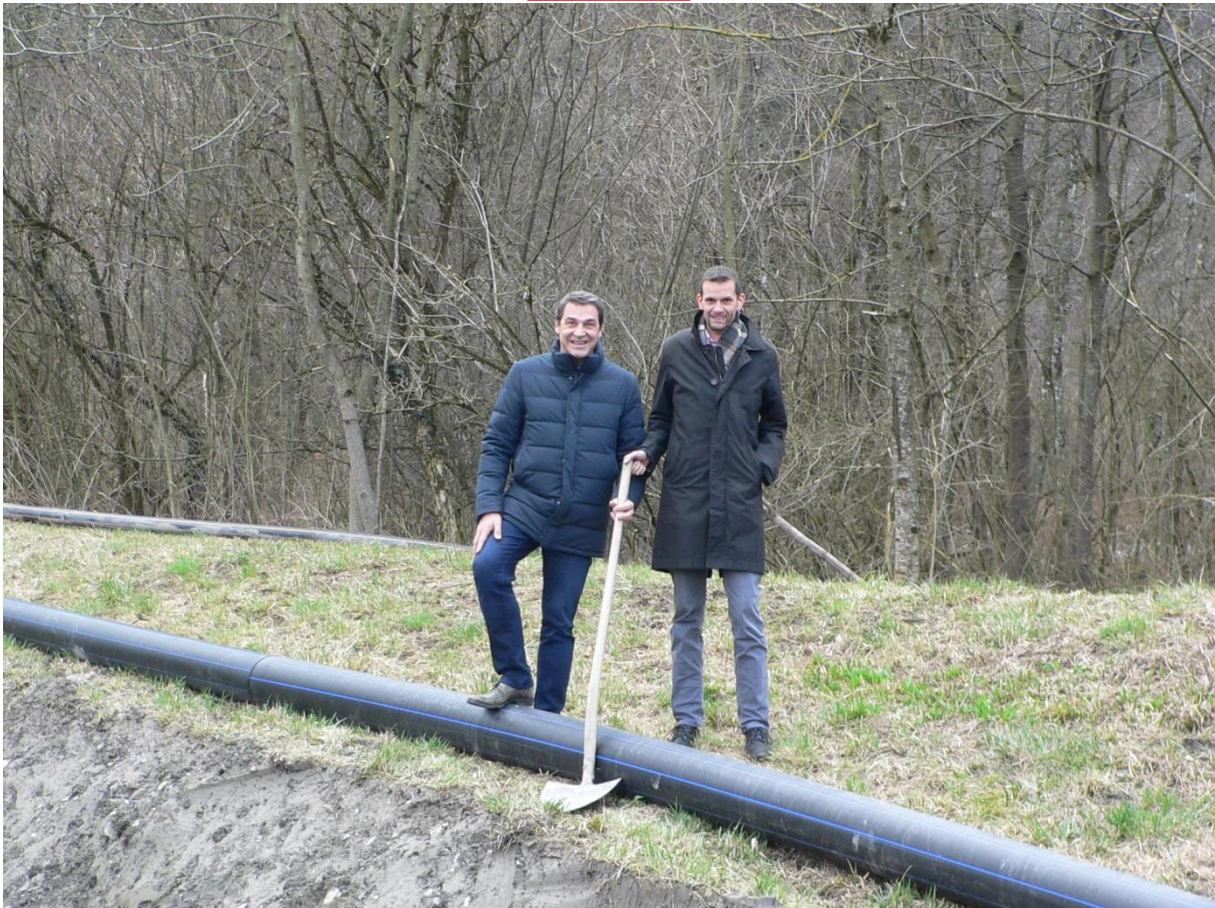
MM. Etienne Roy, Vice-Président d'Avançon Energie SA (à g.) et Laurent Lattion, Président, lors du début des travaux
